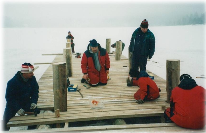
Talvella 2009 rakennettiin uutta venelaituria kylän satamaan.
